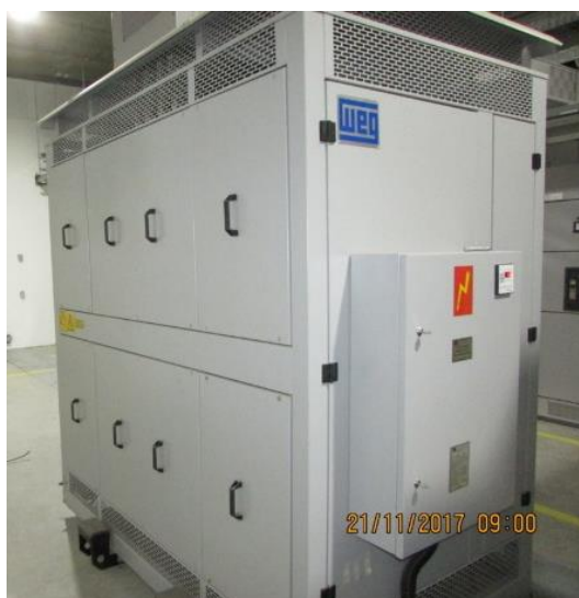
Figura 26 – Transformador de potência à seco
