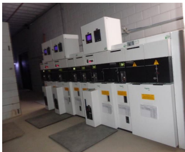
Figura 24 – Cubículo de distribuição em Média Tensão
