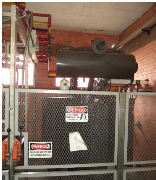
Figura 25 – Transformador de potência à óleo
